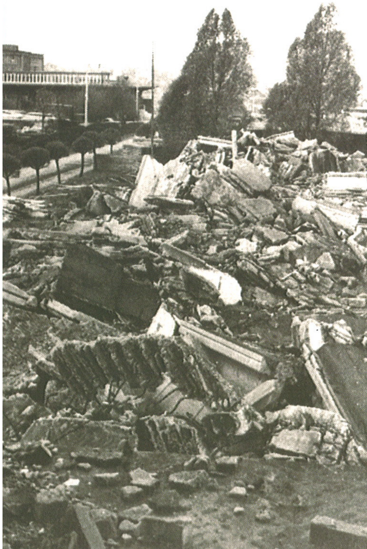
Sådan så fabriksområdet ud efter sprængningerne af de militære fremstillingsanlæg. Alle nazisternes produktionsbygninger fra 1938 og fremefter blev jævnet med jorden.
